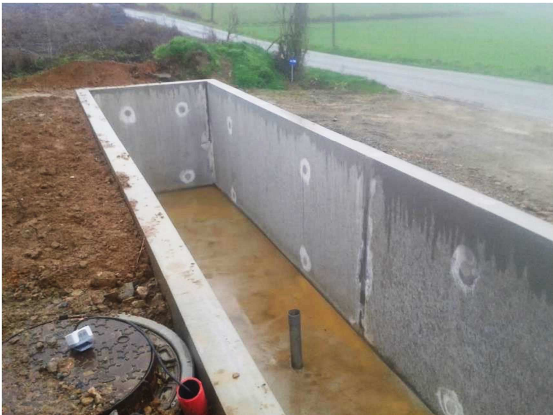
Vue 10 : Vue du local d'équarrissage semi-enterré (en cours de finition)
