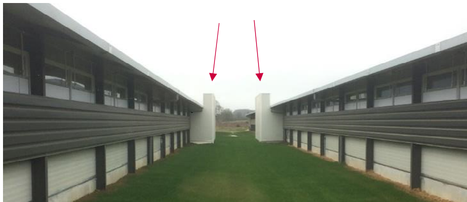
Figure 8 : Caissons de collecte des poussières et odeurs sur les bâtiments 2 et 3
