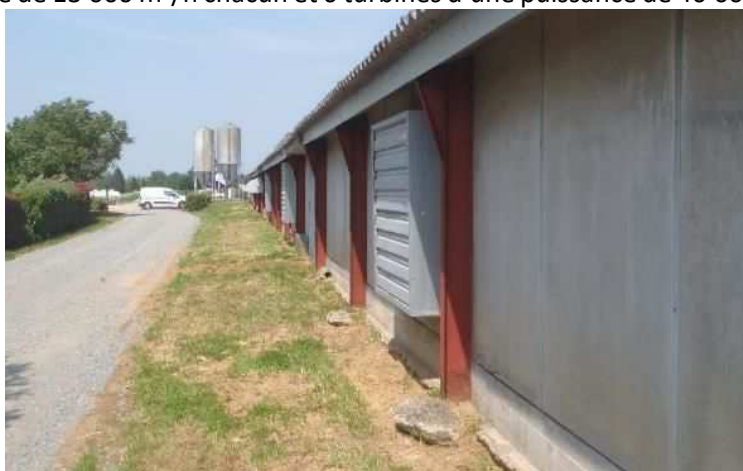
Figure 6 : Grille extérieure des ventilateurs sur le bâtiment 1
