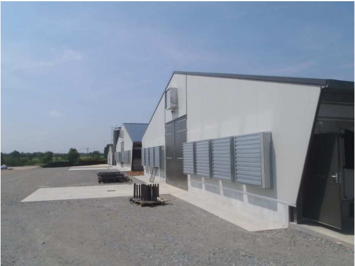
Vue 9 : Vue depuis l'angle Sud-Est du site sur les pignons Sud des bâtiments
